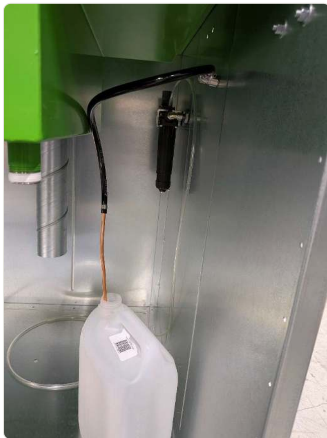
Insida (steg 3): svart slang ansluten på fästet, kopparröret matas ner i thinnerdunk.
